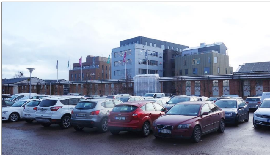
Några av de byggnader som redan uppförts i Kopparlunden Mitt enligt detaljplanen från 2008. Ytterligare byggnader har tillkommit sedan bilden togs i december 2019. Här finns en k-bestämmelse som säger att fasaden mot Varmvalsvägen skall bevaras, vilket också gjorts.
