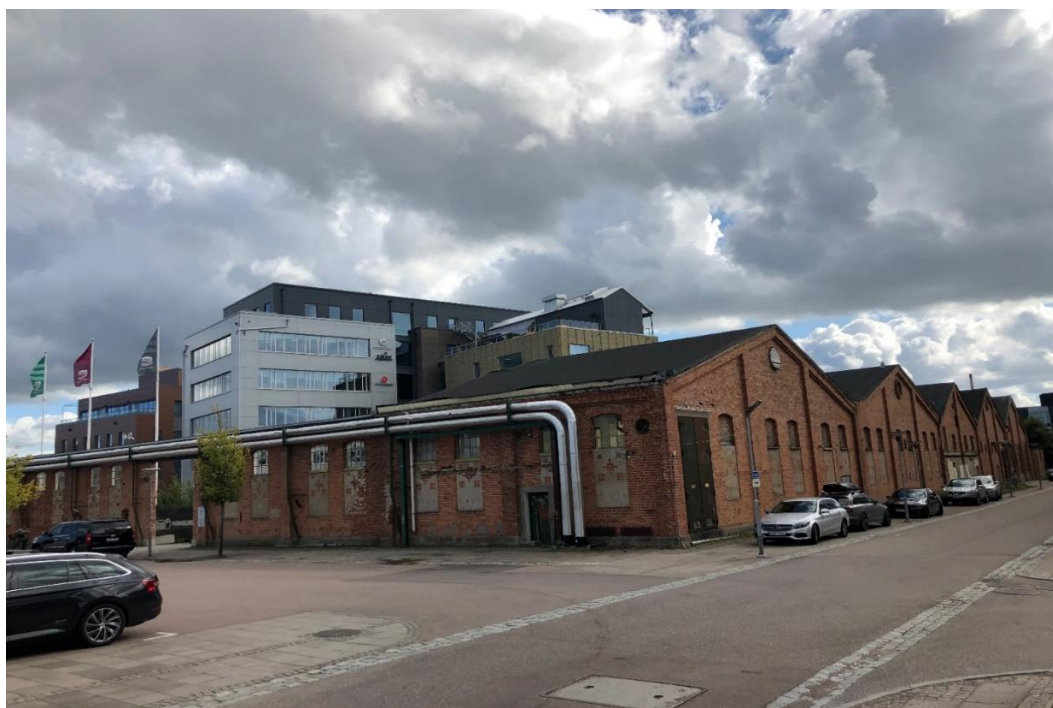
Figur 17. Nya byggnader har uppförts innanför de bevarade yttermurarna av byggnad 27-27A.
