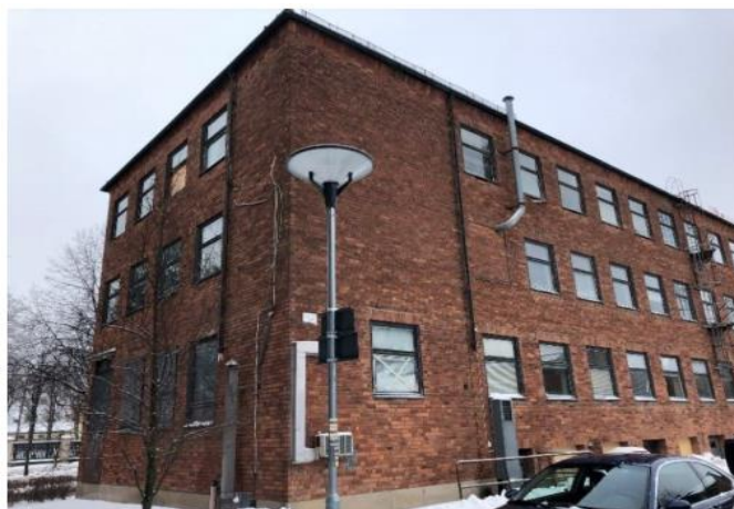
Figur 16. Byggnad 153, laboratoriet från år 1940 som föreslås rivas. (Foto ur kulturmiljöutredning, rev 2020)
