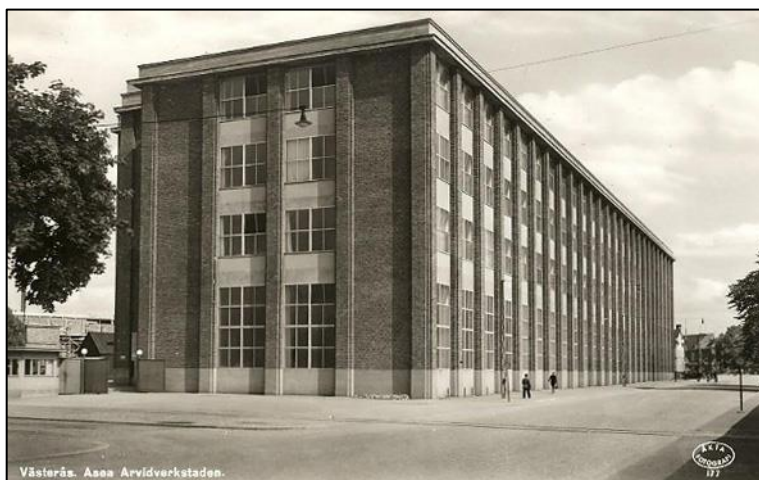
Figur 7. Arvidverkstaden som den ursprungligen såg ut, sedd från väster. Vykort från omkring 1940.
