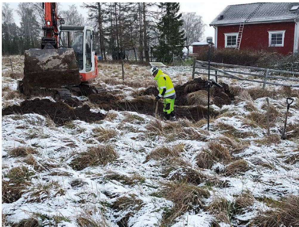
FIGUR 2. Sökschaktning inom objekt 13. Foto: Fredrik Andersson, SAU.
