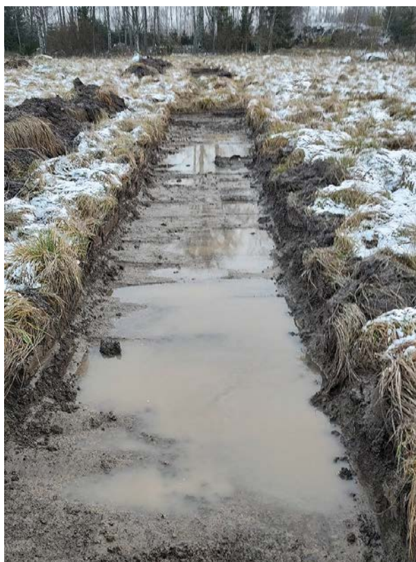
FIGUR 3. Sökschaktningen inom framför allt objekt 13 försvårades av att åkermarken var mycket vattensjuk. Schakten blev snabbt vattenfyllda när vattnet sipprade ner från den omkringliggande matjorden. Foto: Fredrik Andersson, SAU.
