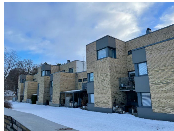
Bild 5: Gestaltungsningen på närliggande fastighet Hedvig 1, "Ganebrohallarna". Kuber och rätblock med en fasad av gult tegel och den andra fasade sidan består av en putsad vit fasad. Likt föreslagen gestaltungsning på Hagadal 1 så har även dessa byggnader takterrasser. Byggår runt år 2006. Framsida ut mot Köpingsvägen.
