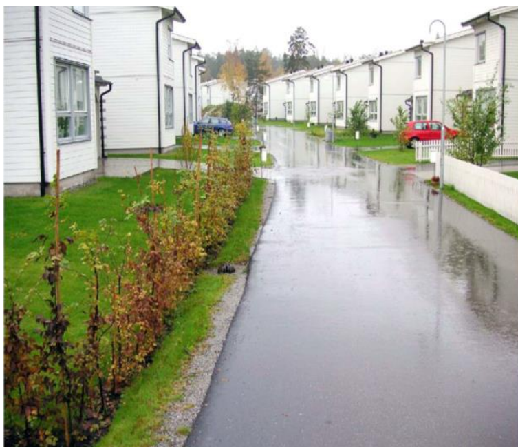
Figur 16. Exempel på hur ett grusdike inom ett bostadsområde kan se ut. Bilderna kommer från Stockholm Vatten och Avfall.
