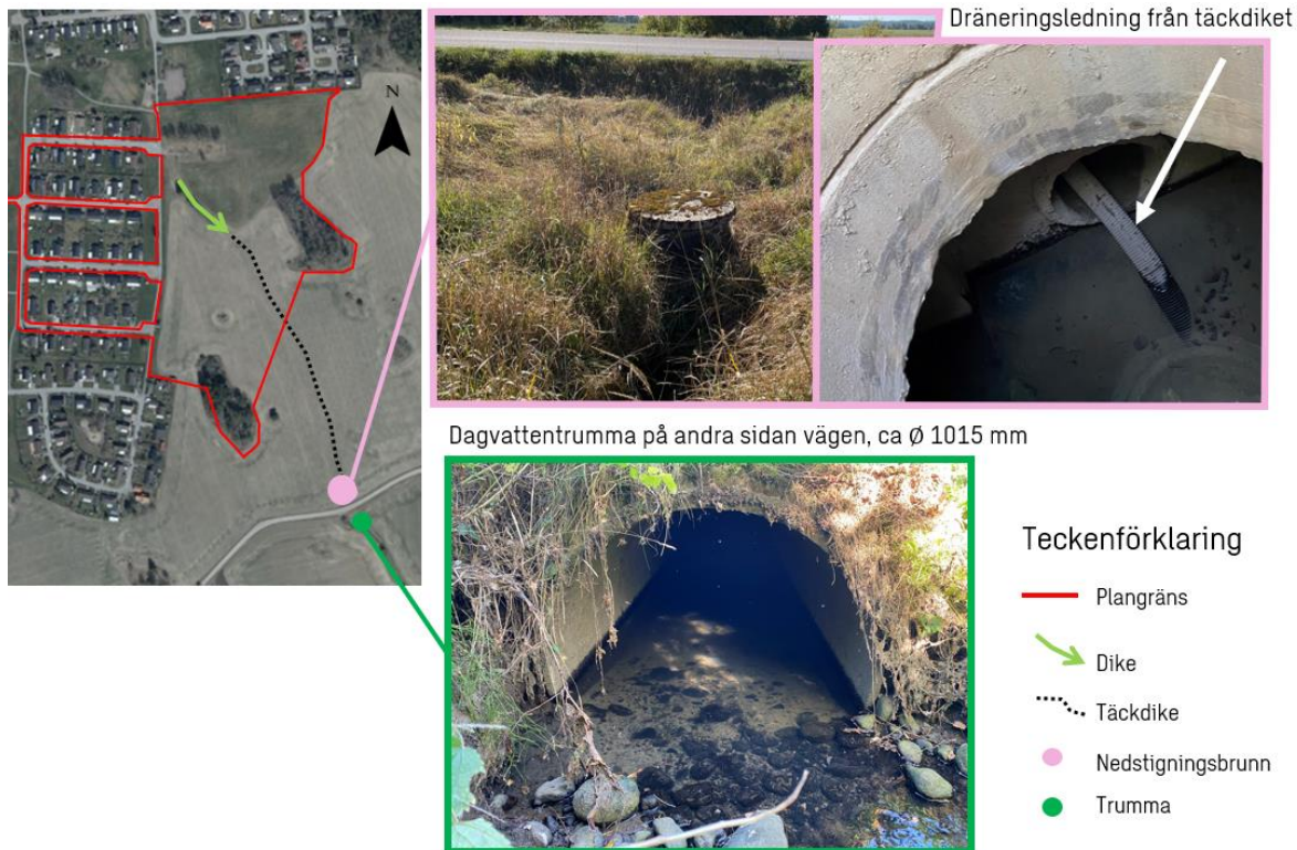
Figur 10. Bilder på dagvattenbrunnen samt dagvattentrumman som vattnet från planområdet leds igenom, samt förtydligande av hur täckdiket sträcker sig genom planområdet.
