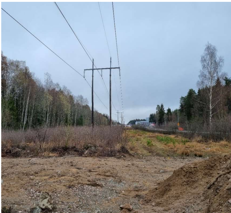
Figur 7-6. Del av ledningsgatan på våren där spår av markarbeten syns, samt uppslag av björksly och små tallplantor (Foto: Norconsult)
