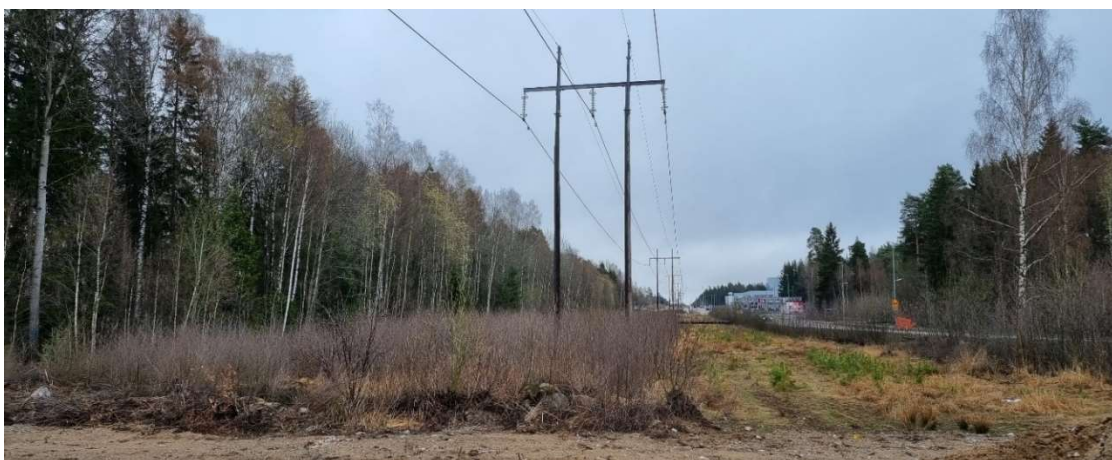
Figur 5-1. Ledningsgatan central i området i öst-västlig riktning.
