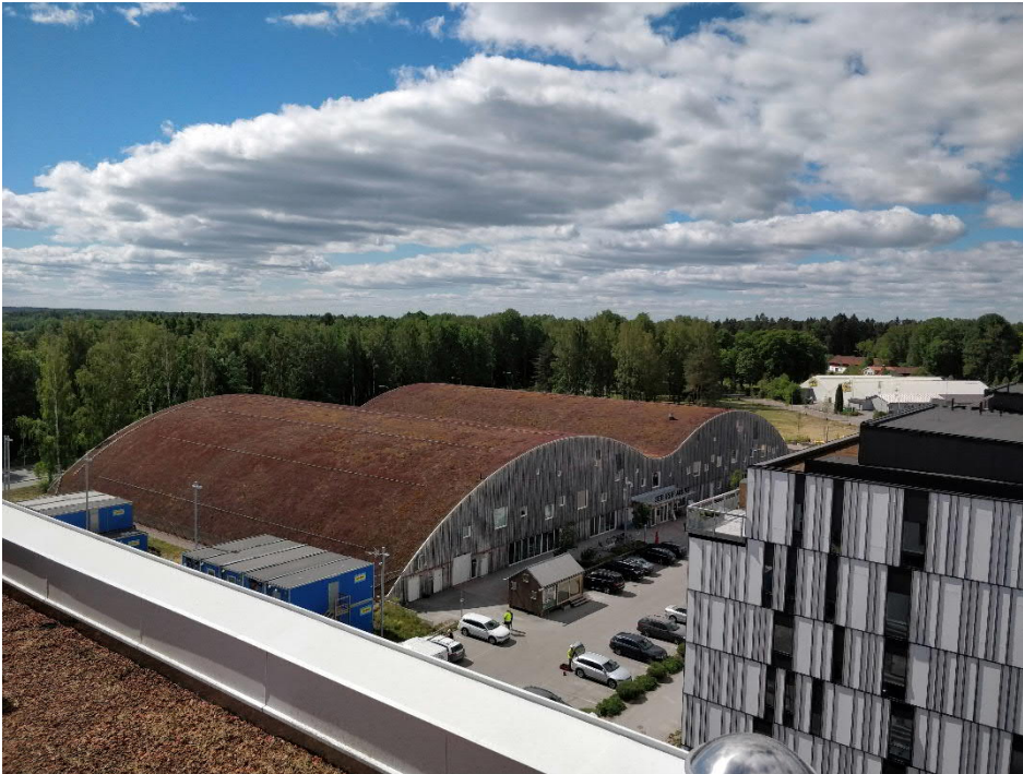
Figur 23. Exempel på ett extensivt tak på en byggnad. Foto: Sweco.
