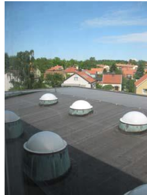
Figur 7 Foto på taket med kupolerna i koppar (Kulturmiljövård Mälardalen).
