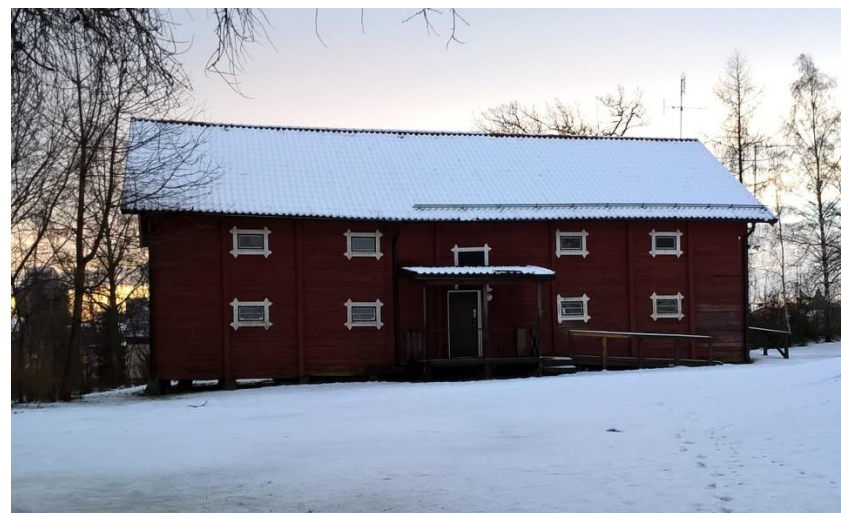
Figur 4 Ladans norra fasad.
