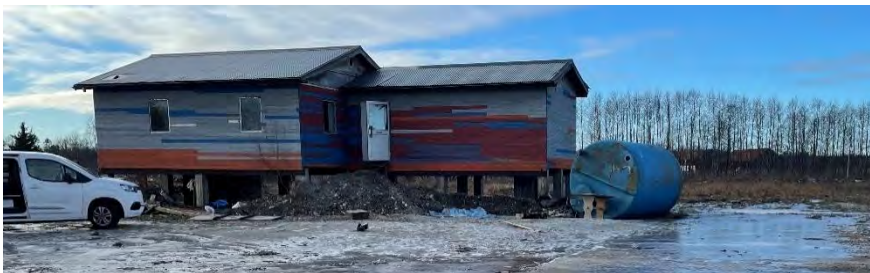
Figur 2.16 Foto av befintlig byggnad. Byggnadens grundläggning har ingen kontakt med markytan.
