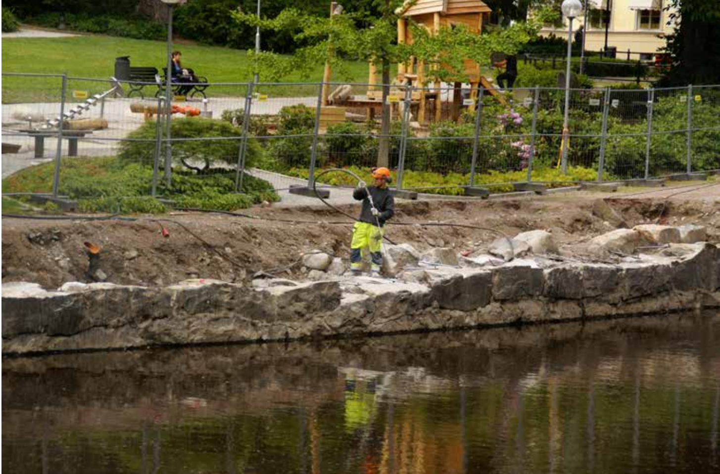
En del av muren längs Svartån renoverades 2010.
