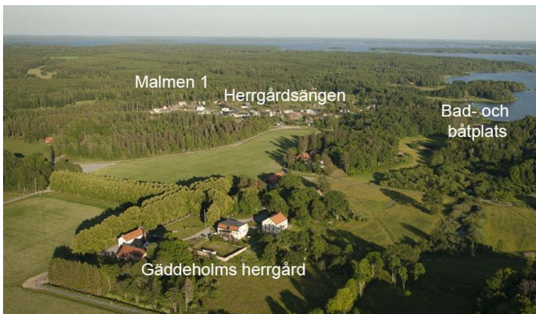
Figur 4-1. Flygfoto över området Gäddeholm. Källa: Västerås stad.
