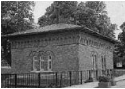
Bild 8. Turbinhuset, uppfört 1891 för att förse företaget med elektricitet, kom att bli ASEA:s första byggnad i Västerås.
