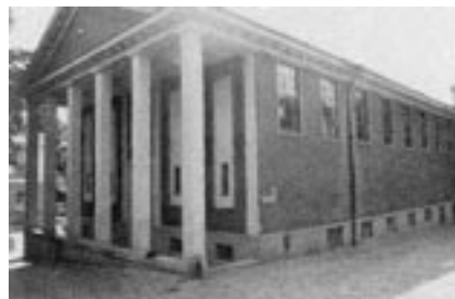
Bild 44. Vid slutet av 1920-talet byggs en gymnastiksal i nyklassicistisk stil till elementärläroverket.
