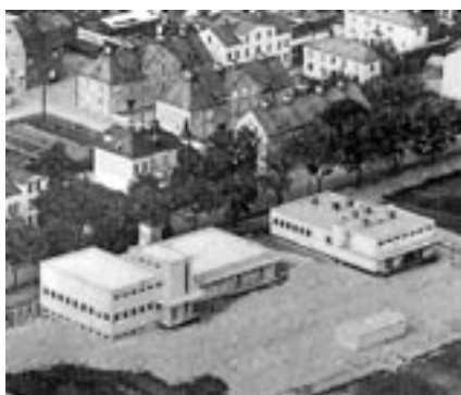
Bild 20. Bageri och charkfabrik ritad 1930 av KF:s arkitektkontor för Kooperativa föreningen Svea i Västerås. I bakgrunden skymtar Byggnadsföreningen Viktoria.
