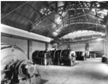
Bild 17. Ångkraftverkets maskinsal med dess turbiner. Foto från år 1930.
