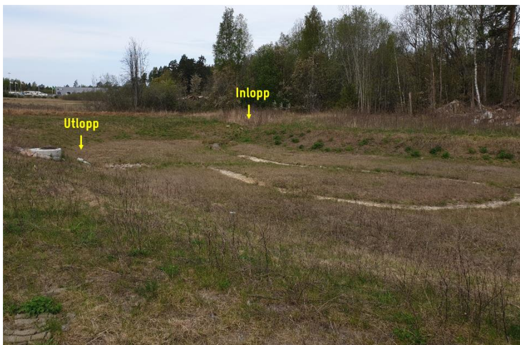
Figur 8. Bild över befintlig fördröjningsdamm (damm nr. 1 i Figur 7).
