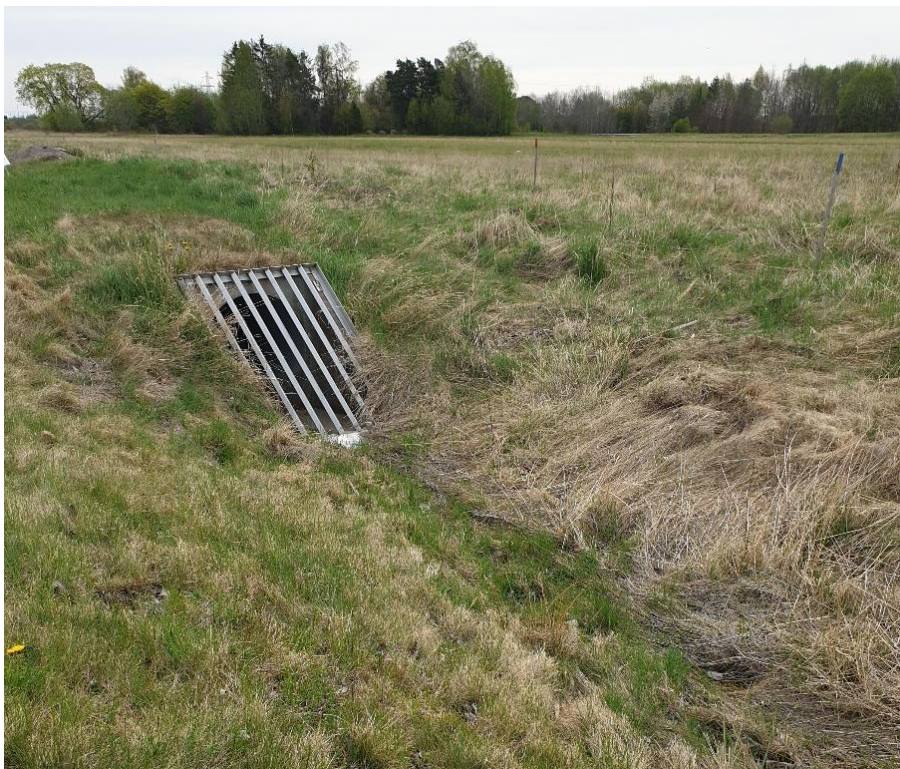
Figur 10. Inlopp till dagvattenkylvert vid Stomnätsgatan (nr. 4 i Figur 7).
