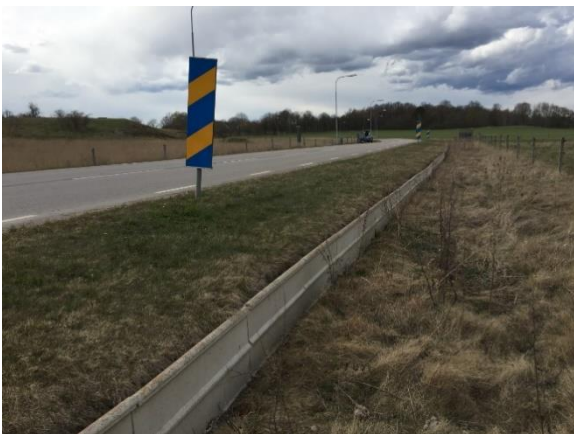
Figur 11. Groddjursbarriär anläggs av ett tätt material och bör vara minst 40 centimeter högt med en överliggare på cirka 5–10 centimeter för att motverka att groddjur klättrar över. Det är viktigt att skarvarna är tätta. Längs barriären anläggs en stödremsa med grus/stenkross ovanpå markkväv för att motverka igenväxning av barriären. Stödremsan bör vara cirka 50 centimeter bred. Barriären kan anläggas av exempelvis L-stöd.
