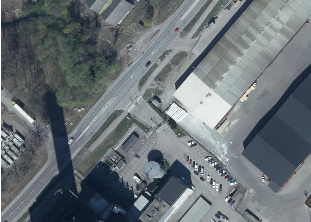
Figur 26. Korsning A, Sjöhagsvägen och infart till Mälarenergi AB Kraftvärmeverk. Korsningen är av typ C.
